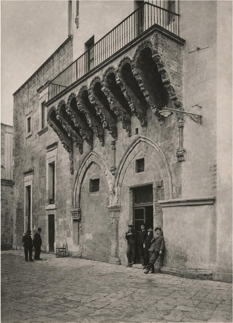
Brindisi - Loggia medioevale Babamo
