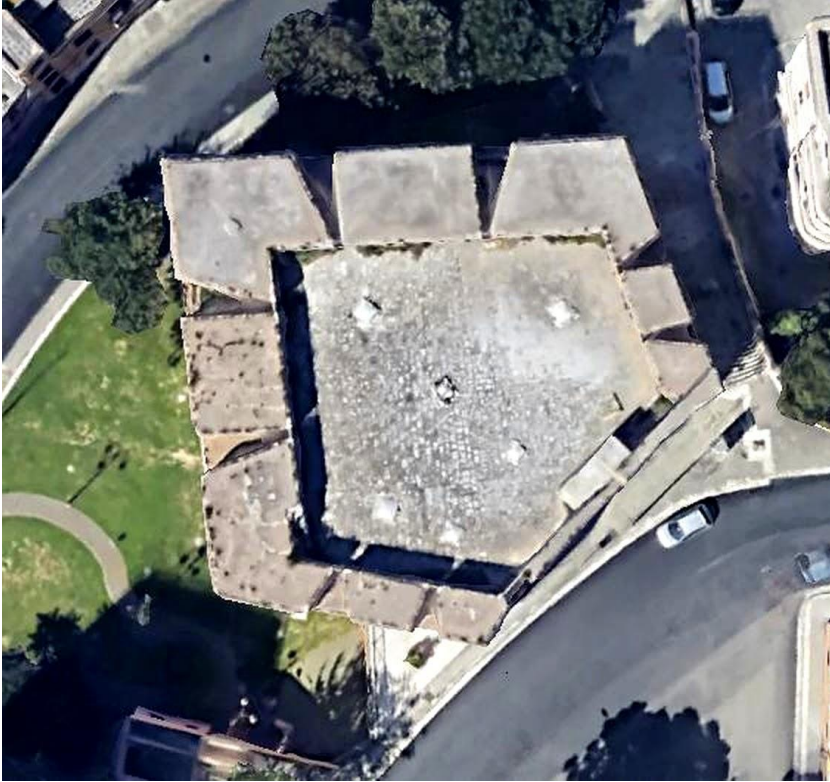
Fig. 9. Bastione San Giacomo, dettagli dei merloni (da Google Earth).
