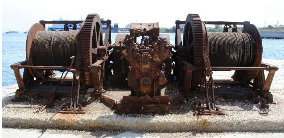
Il motore visto da Nord
