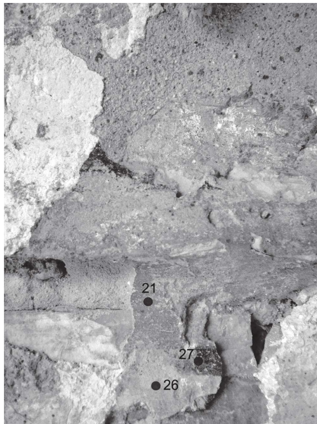
Fig. 3b. Navatella settentrionale: dettaglio degli intonaci dipinti.
