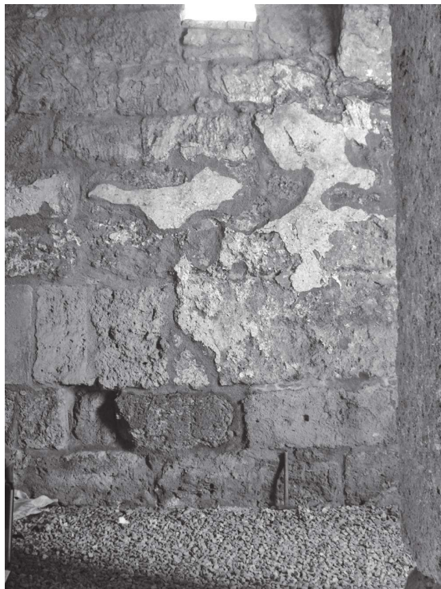
Fig. 3a. Navatella settentrionale: muro orientale.
