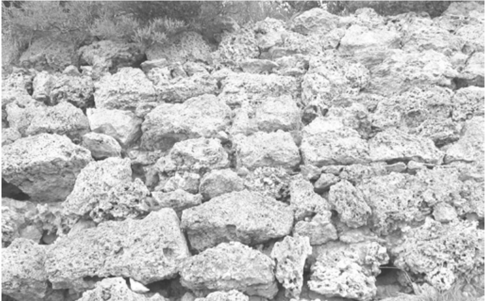
Fig. 1 - Brindisi, Isola di Sant'Andrea. Muratura esterna.
