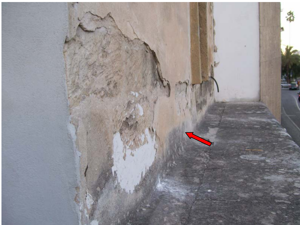
Figura 19: Particolare prospetto Nord Est
