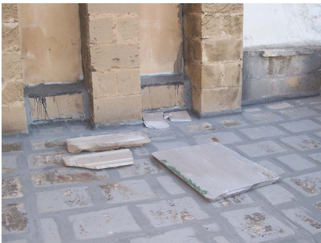
Figura 7: Solaio sacrestia – base del campanile
