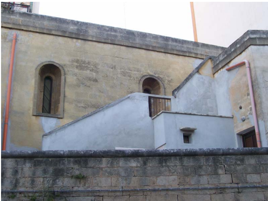
Figura 21: Particolare prospetto Nord Est
