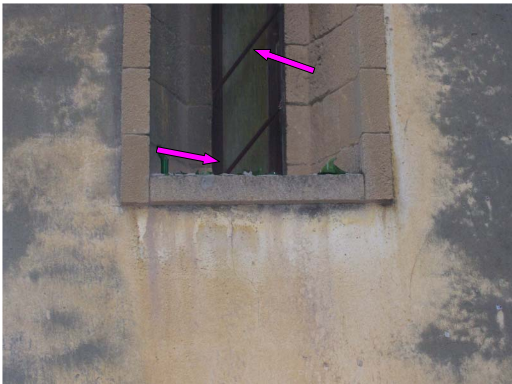
Figura 26: Infisso centrale lato via De' Flagilla
