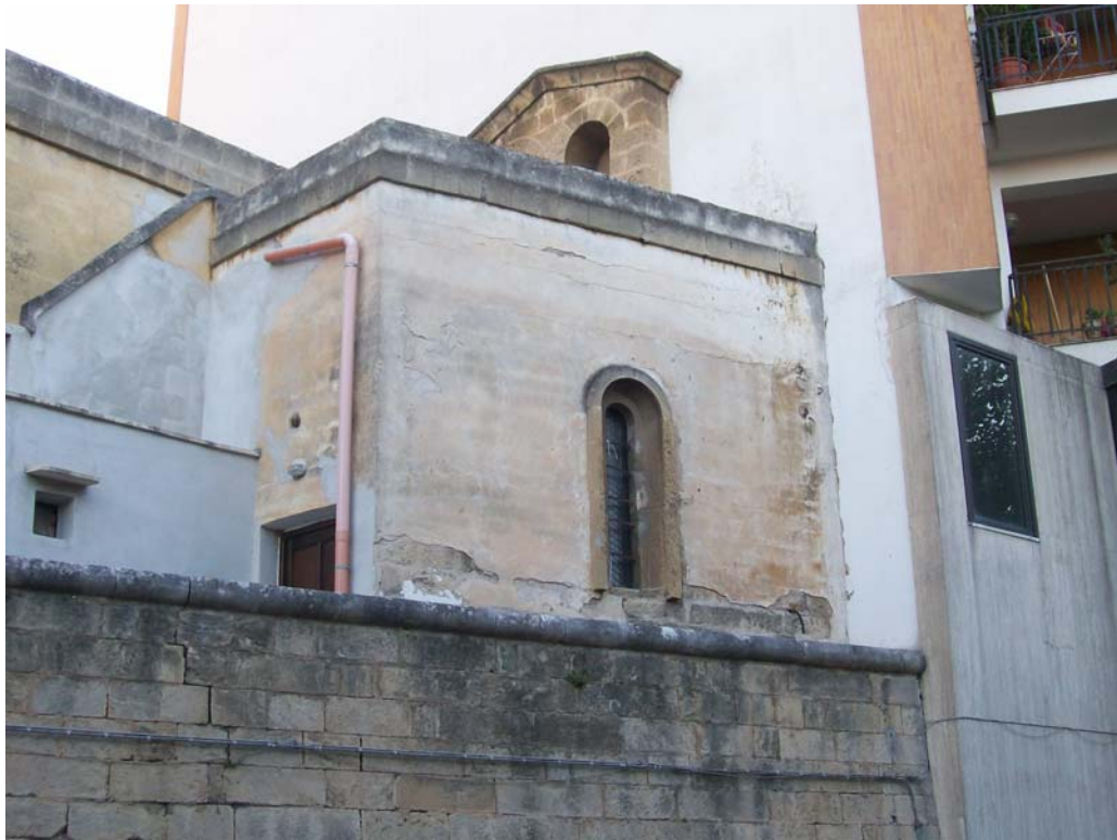
Figura 18: Particolare prospetto Nord Est
