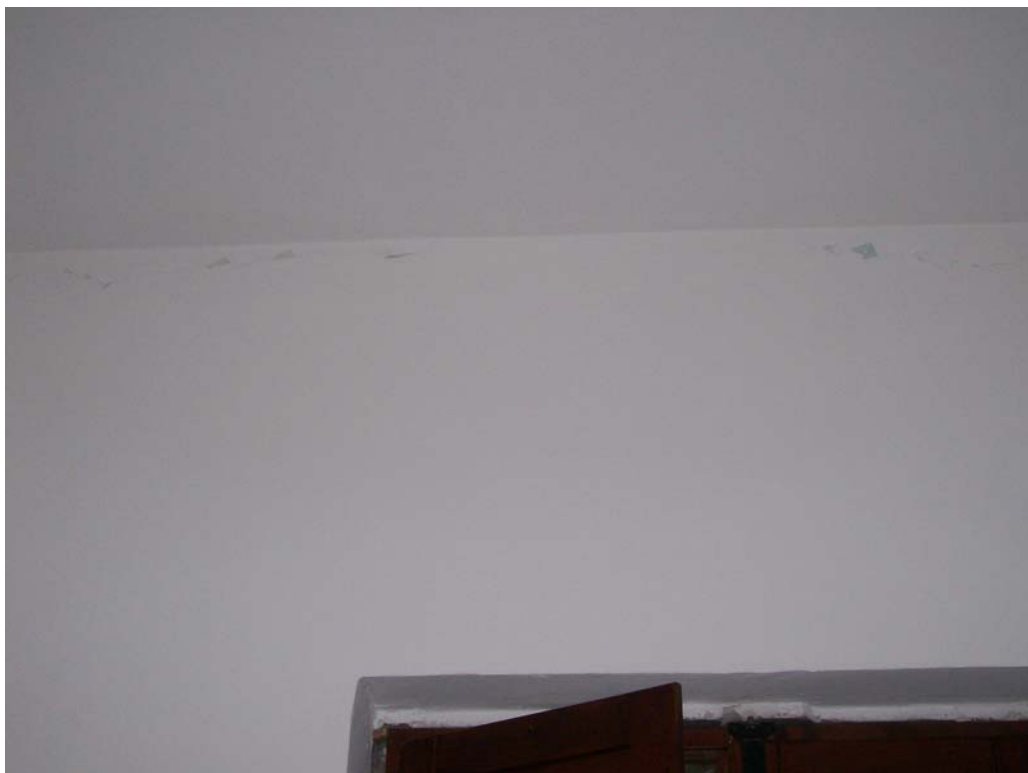
Figura 24: Particolare murature interne, salone
