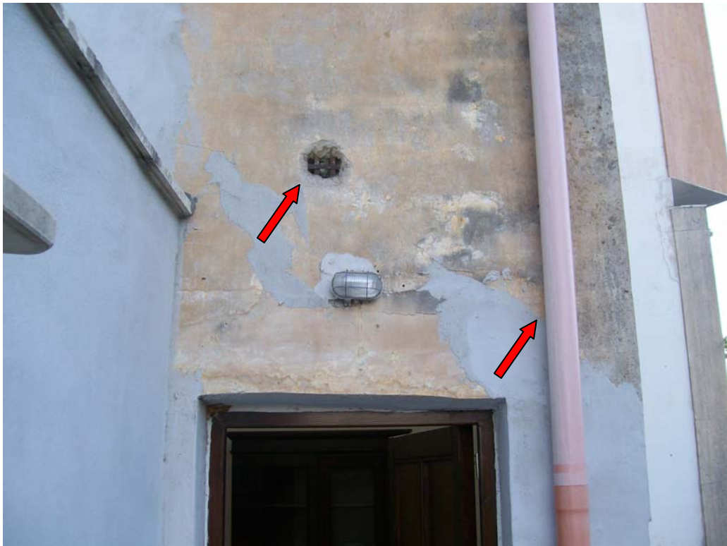
Figura 20: Particolare prospetto Nord Est
