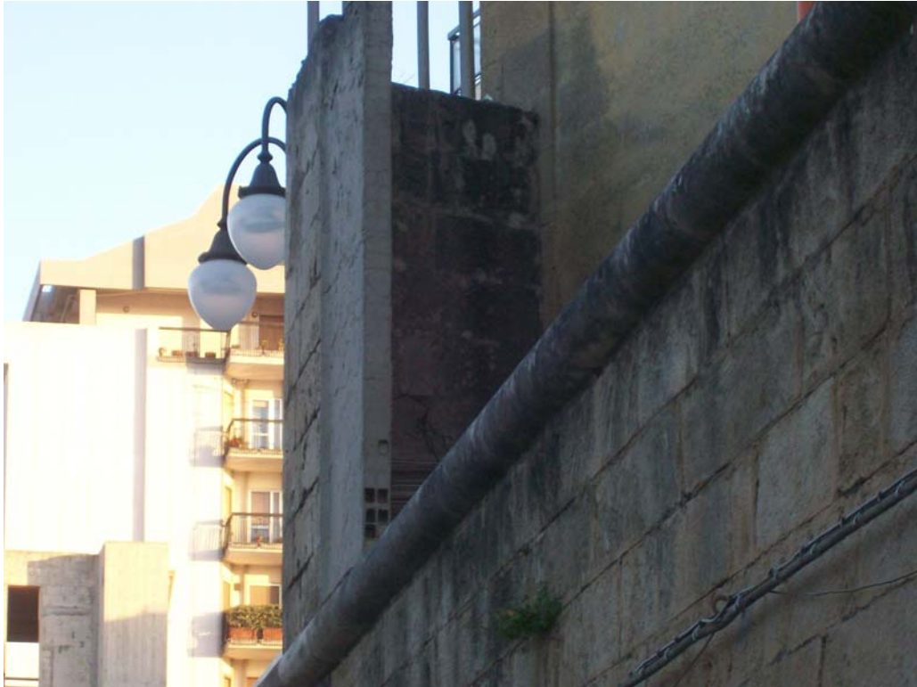
Figura 22: Particolare prospetto Nord Est
