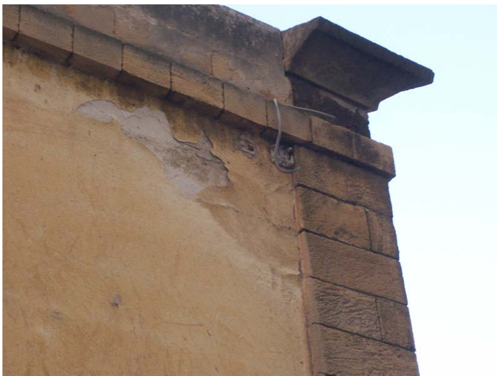
Figura 16: Particolare prospetto Ovest lato destro
