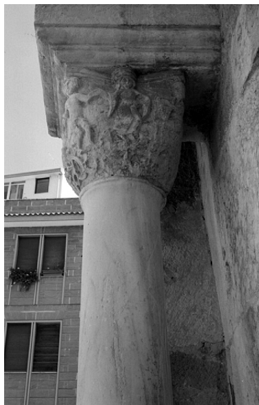
Fig. 13. Brindisi. Chiesa di San Giovanni al Sepolcro: colonna del portale in marmo Pentelico.
