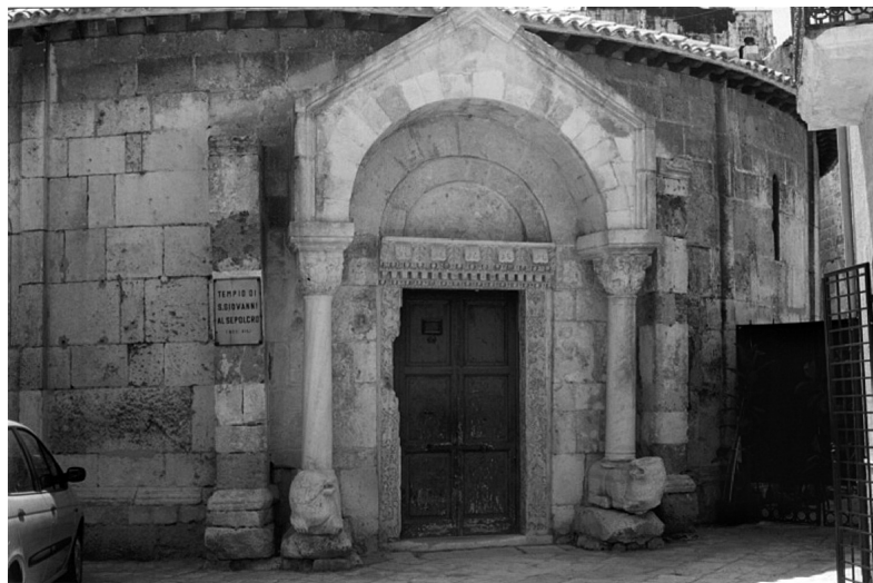
Fig. 11. Brindisi. Chiesa di San Giovanni al Sepolcro: portale.
