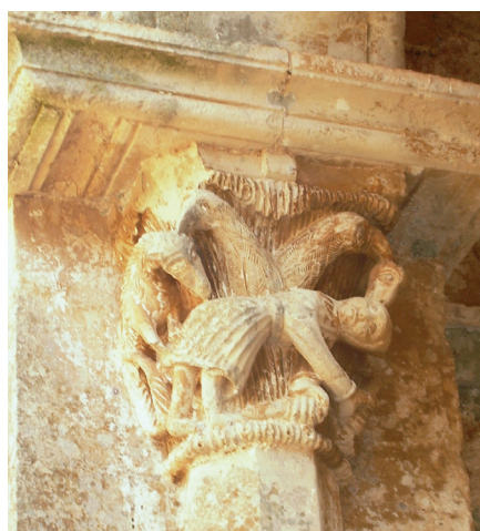
Fig. 21- Abbazia di S. Maria di Cerrate, capitello della loggia
