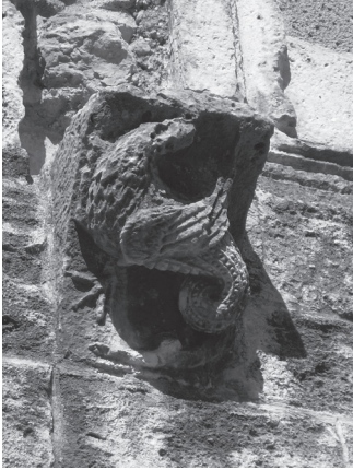
Fig. 15: Brindisi, chiesa di S. Lucia (già della SS. Trinità). Prospetto meridionale, basilisco
